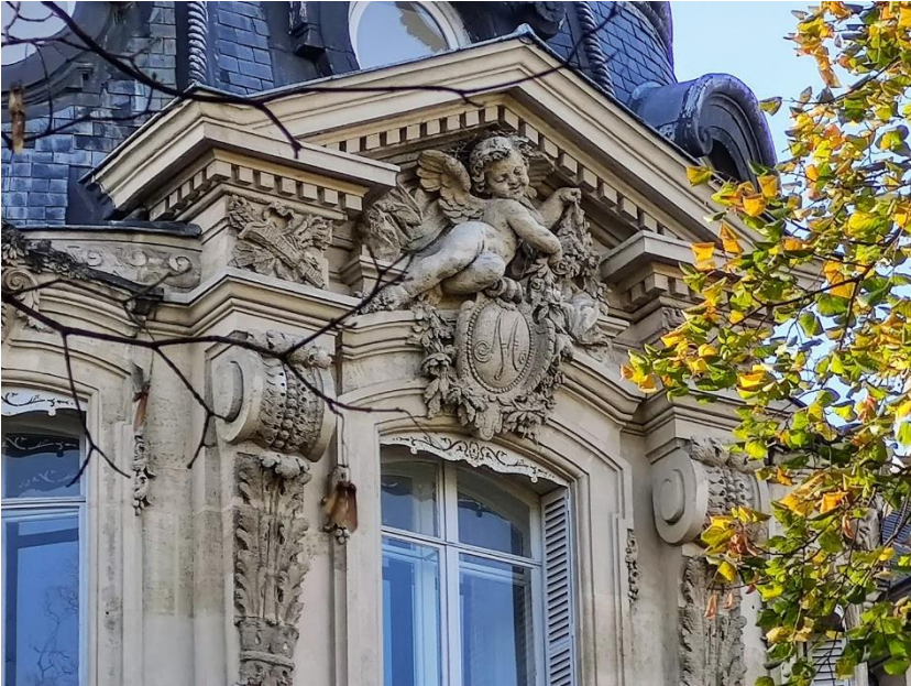
Façade sur le parc (détail)
