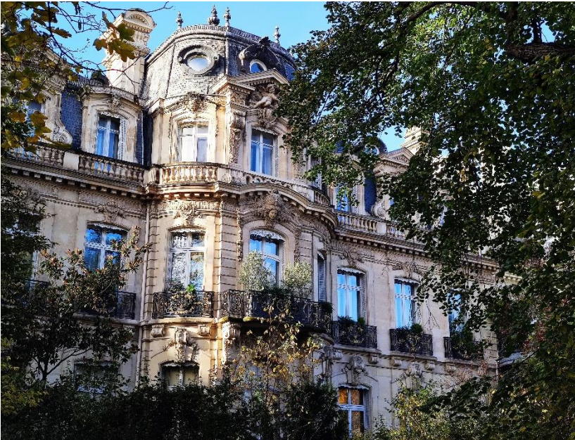
Façade sur le parc
